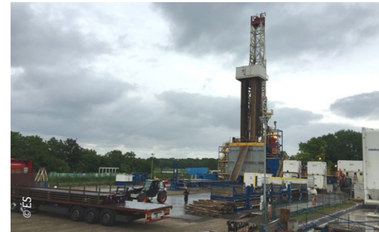
Bohrturm der Geothermieanlage in Illkirch-Graffenstaden. Tour de forage de l'installation géothermique à Illkirch-Graffenstaden.
